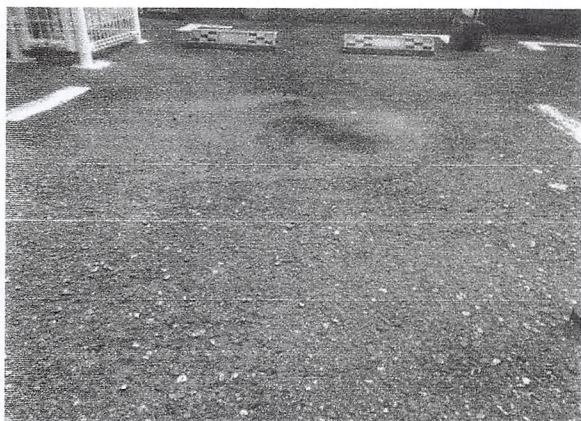
○9月20日 A棟防災倉庫横駐車場陥没アスファルト補修作業
