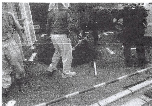
○9月20日 A棟防災倉庫横駐車場陥没アスファルト補修作業
